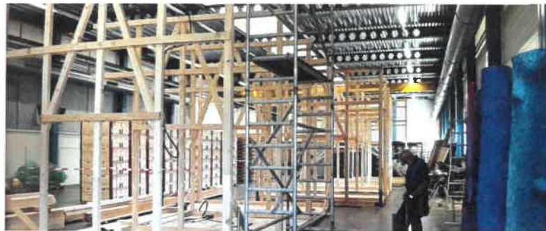
Grundkonstruktion für das Bühnenbild zur «Grünen Fee» in der damaligen Halle der ABB.
